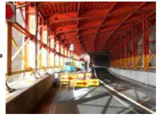
片側交互通行の状況(北上市側)
