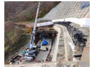
仮設プロテクタ撤去作業イメージ
