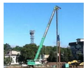
土留工の作業イメージ
