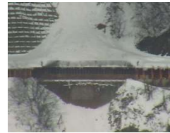
雪崩の状況(H28.2.18撮影)
